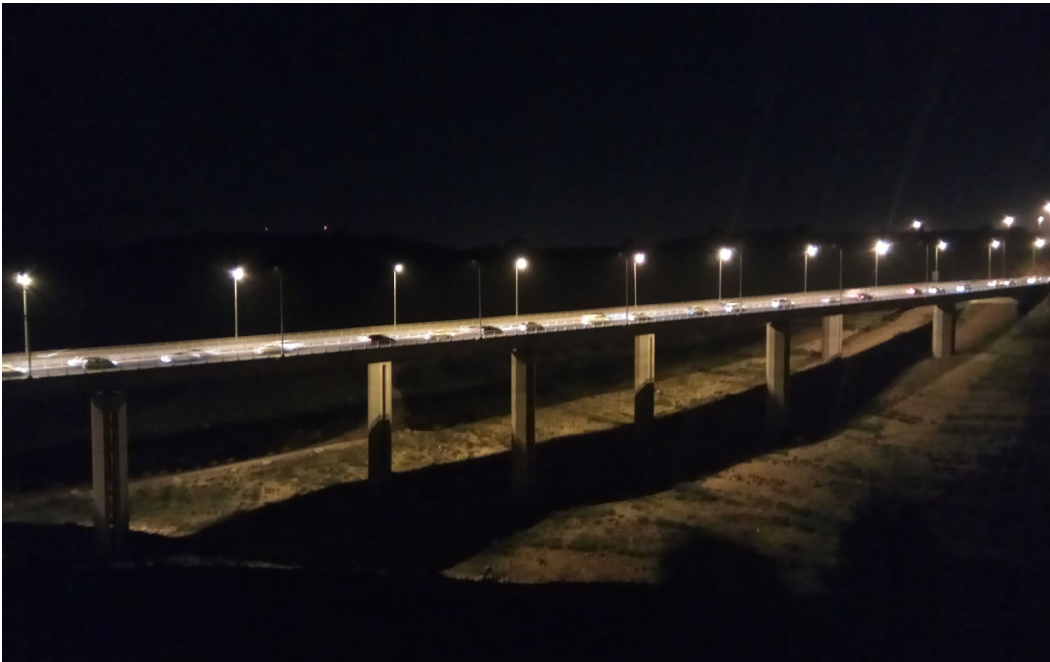
תמונה 4: הארת דרך בגשר כביש 85 מעל שטח רגיש אקולוגית (נחל עמוד), הפרשי הגובה מעבר לשטח המיסעה לא חושבו בתכנית התאורה ולכן נוצרת הארה מיותרת של הנחל - אזור ברגישות אקולוגית גבוהה | צילום: מיכל ניב נאמן.
